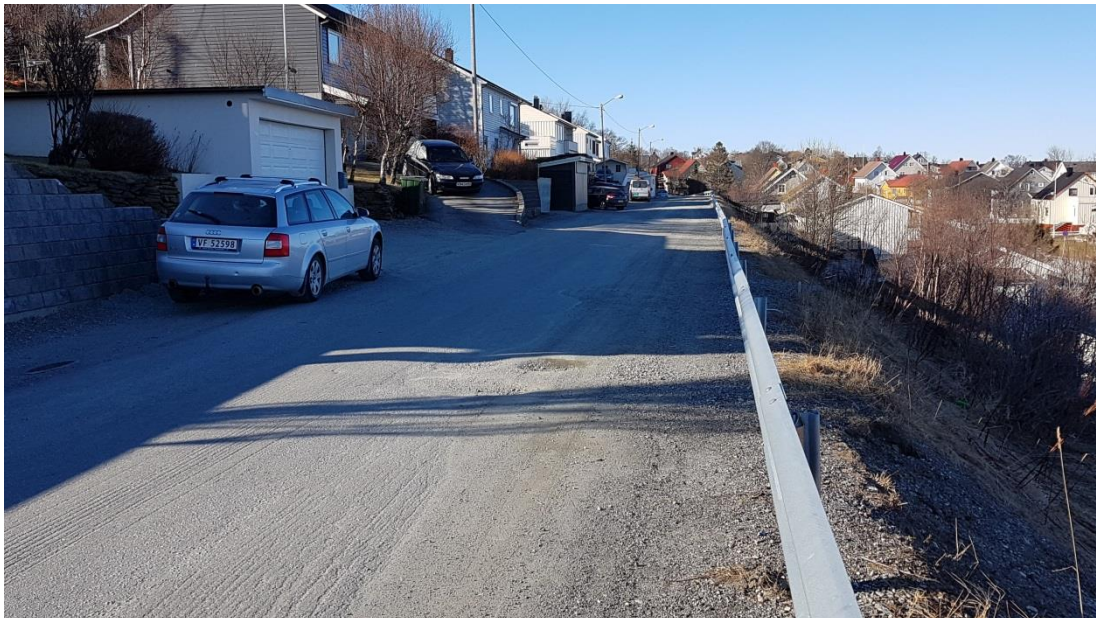
FIGURE 12: DET ER GJORT EN DEL SIKRINGSTILTAK LANGS TYRIHANSVEIEN MED BL.A AUTOVERN OG STØTTEMURER. DET ER BEHOV FOR YTTERLIGERE TILTAK.
